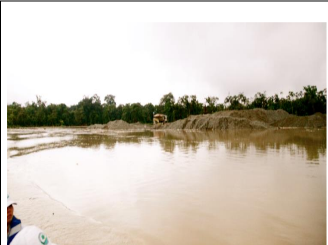
Fotografía 76: Maquinaria y banco de arena
